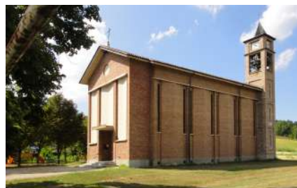
Figura 3.38: Chiesa di Santo Spirito e S. Carlo degli Accorneri.
